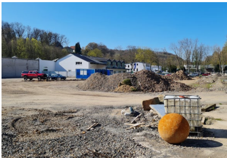
Baubeginn auf dem ehemaligen Gelände des Kürtener Raiffeisenmarktes.
