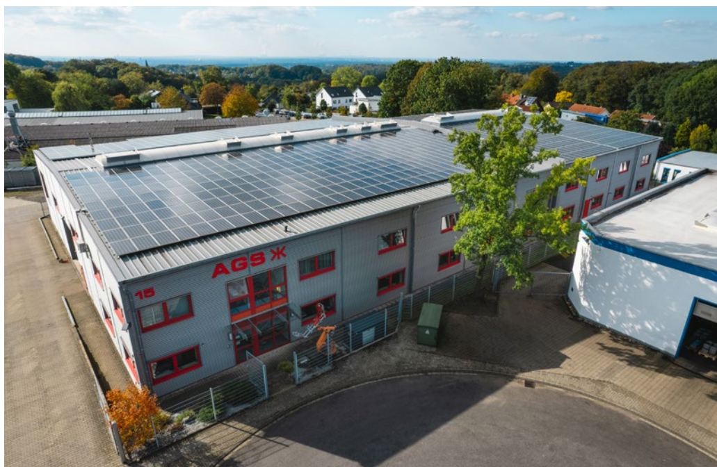
Verwaltung und Produktion werden mit Holzhackschnitzeln beheizt.
