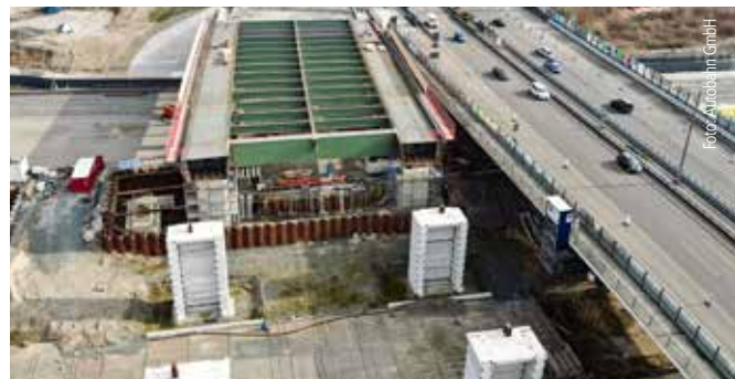
Aus solchen Fertigbauteilen entstehen die neuen Brücken über den Rhein.
